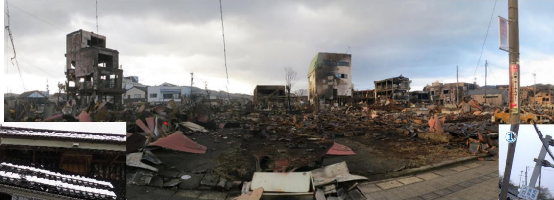
焼失した市街地を北側から撮影した様子（輪島市）
