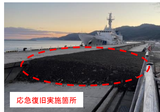
応急復旧の実施状況 (1/5)
