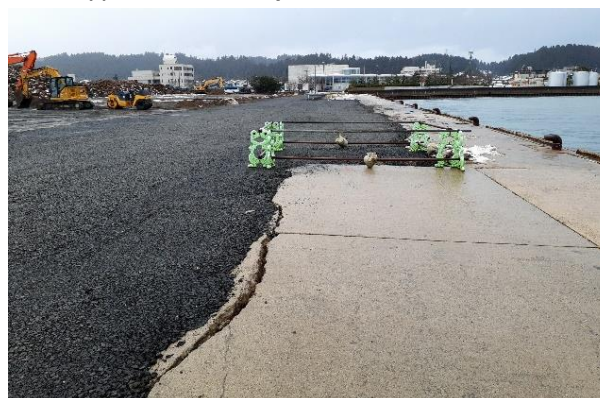
応急復旧後の状況
