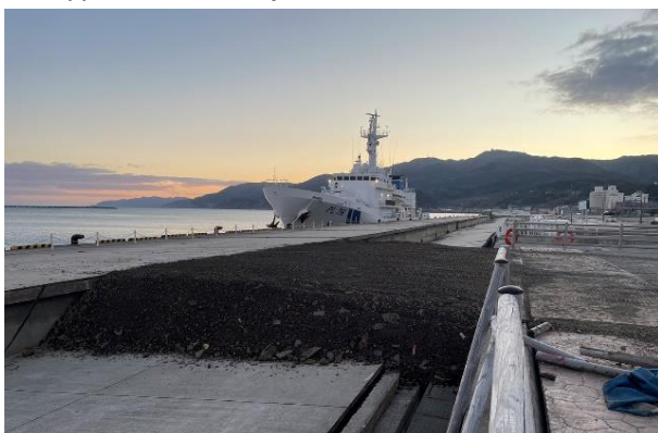
応急復旧後の状況
