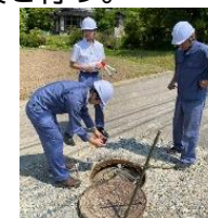
再度災害防止に向けた 被災メカニズム調査（輪島市）
