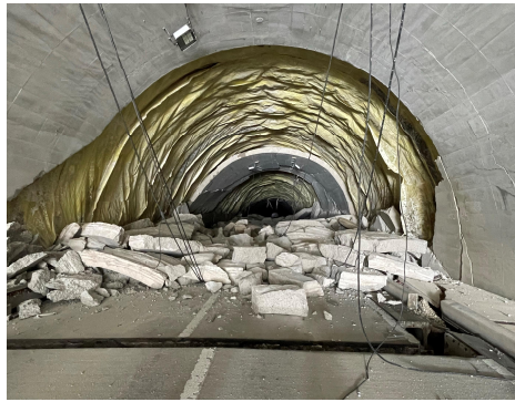
国道249号大谷トンネル（珠州市）
