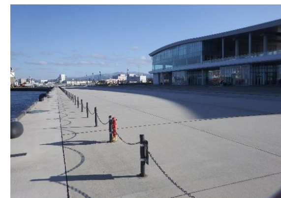
地震後の状況
