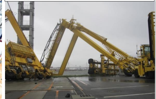
トランスファークレーンの倒壊（大阪港）
