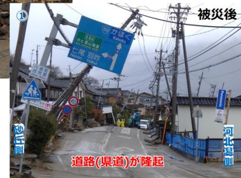
液状化による地盤の流動状況（内灘町）
