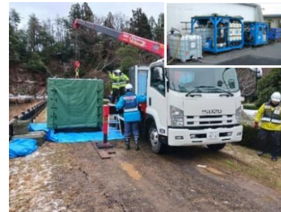
可搬式浄水施設の設置 (石川県珠洲市)
