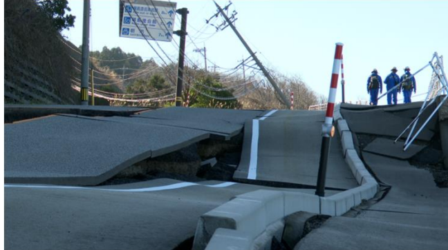
国道249号道の駅千枚田付近（輪島市）
