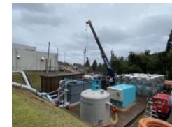
可搬式浄水装置の設置 （珠洲市）
