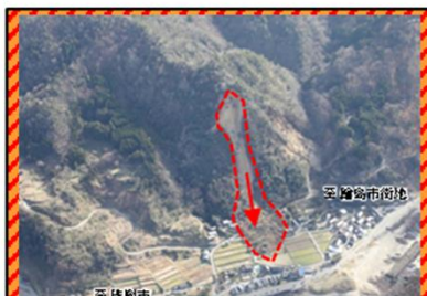
写真② 石川県珠洲市仁江町の地すべり
