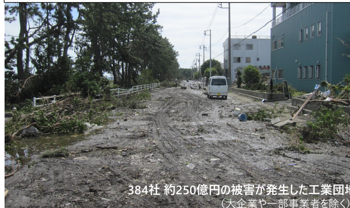
被災した工業団地（横浜港）
