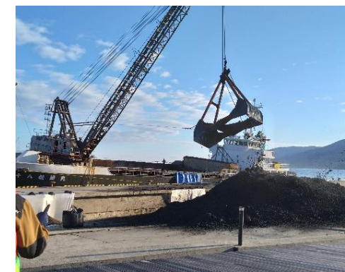
土砂除去作業の実施状況 (1/29)
