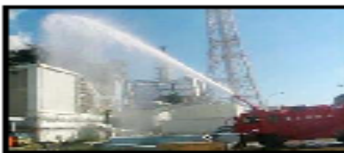
原発への地上放水
